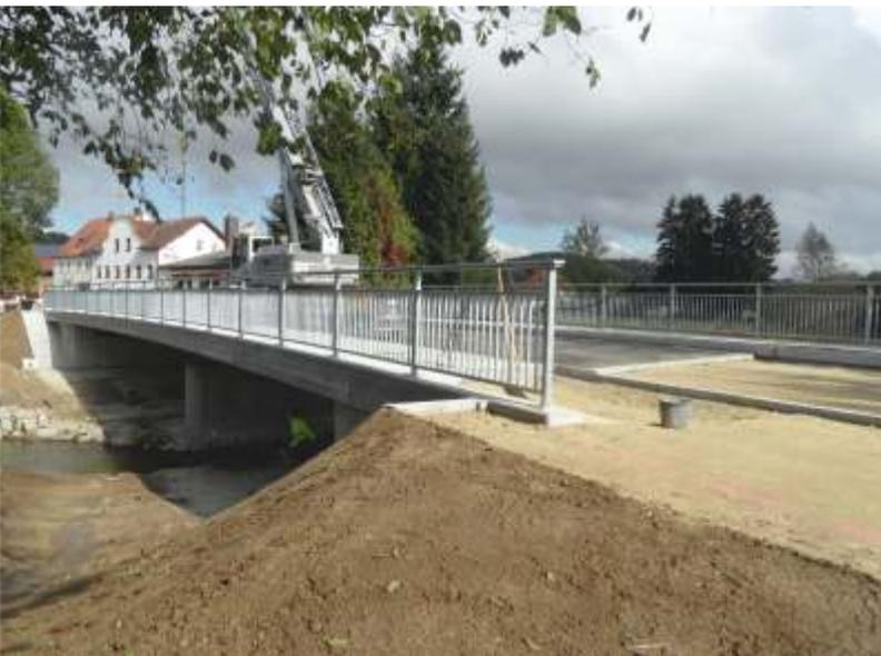
Der am 29. März 2016 begonnene Neubau der Kollbachbrücke ist abgeschlossen, seit dem 20. Oktober 2016 ist die Brücke wieder für den Verkehr freigegeben. Die Brücke wurde mit einer Fahrbahnbreite von 6,50 Meter sowie einem drei Meter breiten Geh- und Radweg und einem 1,25 Meter breiten Notgehweg auf der anderen Seite ausgestattet. Die Stützweite der Brücke beträgt 2 x 14,65 Meter.
